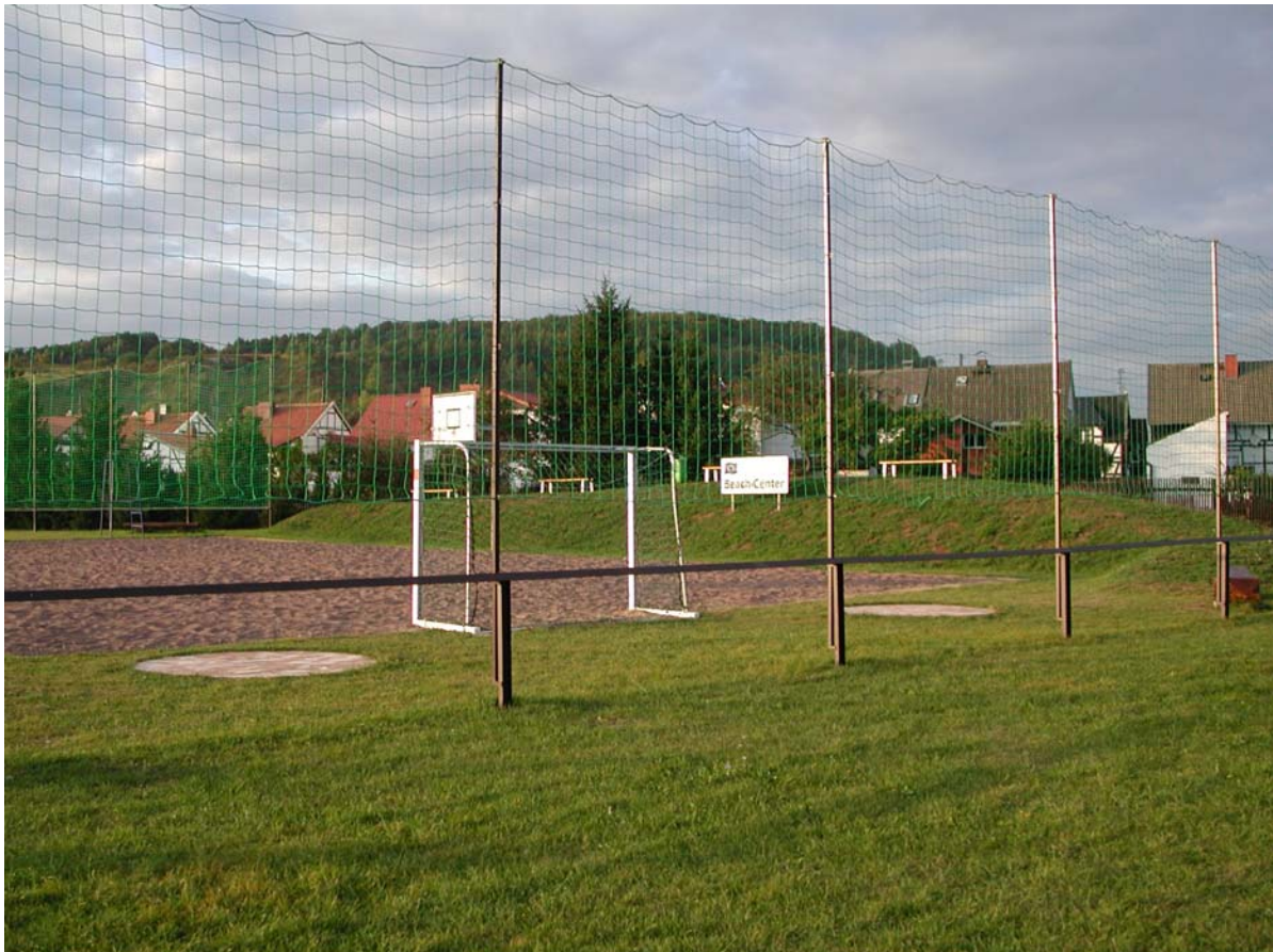
Ansicht Beachsportanlage Niedersachswerfen- vorn im Bild: Kugelstoßring
