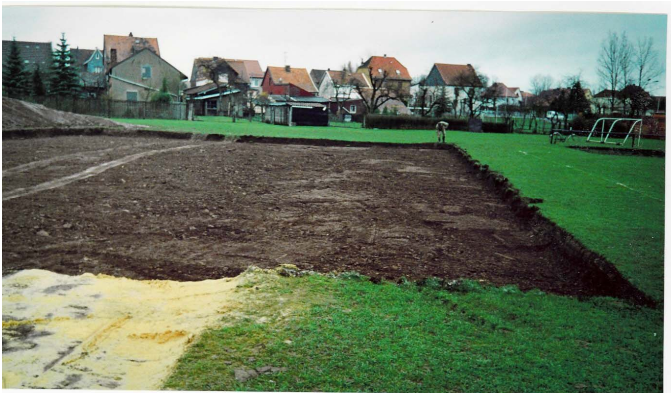
Ansicht: Bauphase/ Anlaufbereich Weitsprung I
